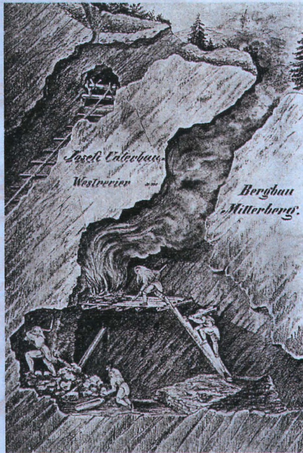
Die Anwendung der Feuersteintechnik im bronzezeitlichen Kupferbergbau wurde erstmals am Mitterberg in Salzburg dokumentiert. Diese Modellzeichnung von J. Pirchl mit Feuerbühne und Rauchabzugskamin entstand gegen Ende des 19. Jh.
